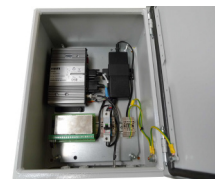
T8 reläenhet i väggskåp med infästning och kablage för Sepura SRG/SCG22 (radioenhet ingår ej)
